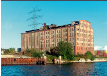
Blick von der „Pionier“ auf das Speichergebäude
