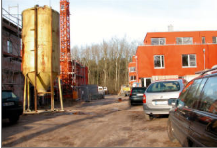
Die „roten Häuser“ während der Bauzeit, um 2003.
